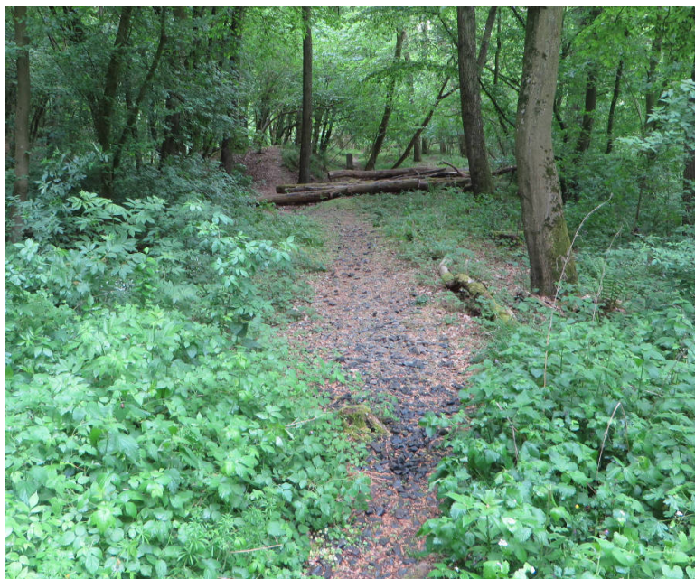
Abbildung 4.45 Blick vom Südportal des Carlsbahntunnels auf den Lückenschluss im NSG. Die Bahntrasse ist noch gut erkennbar.
