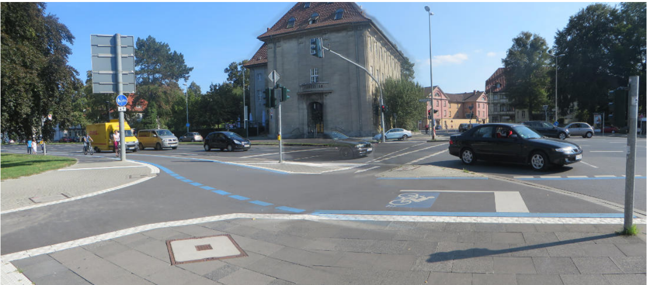
Abbildung 4.7 eRadschnellweg Göttingen am Knoten Weender Tor: Die Radverkehrsflächen sind durch Asphalt und die weiße, gut erkennbare taktile Trennung klar von den Fußgängerflächen abgegrenzt. Aus Platzgründen ist der Radbereich der Route zum Teil auch nur 3 m breit – was trotzdem noch zum komfortablen Radfahren reicht. Die 4 km lange Pilotstrecke des eRadschnellweg Göttingen verbindet seit Frühjahr 2016 den Nordcampus der Universität mit dem Hauptbahnhof. Die etwa 1,8 Mio Euro teure Pilotstrecke wurde zwischen 2012 und 2015 als Forschungsprojekt im Rahmen des Schaufensters “eMobilität in Niedersachsen” von der Bundesregierung gefördert. Bild: Herbert Iba 08-2016
