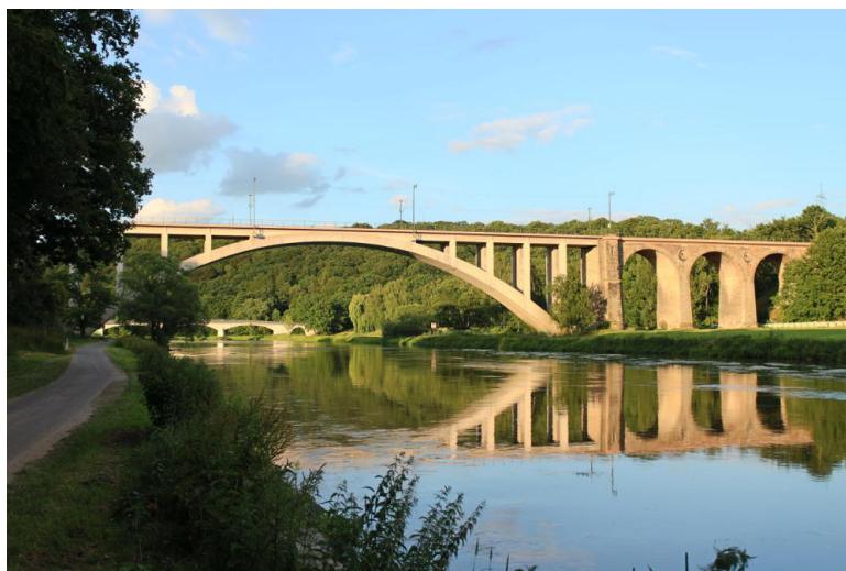
Abbildung 2.23 Eder-Radweg kurz vor Streckenende bei Baunatal-Guntershausen: Blick auf das Bahnviadukt.
