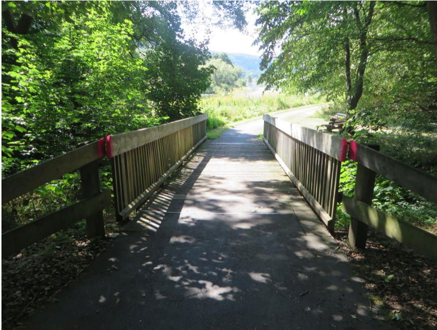
Abbildung 2.16 R1 an der Landesgrenze vor Hann Münden. Hier findet sich beispielsweise eine der engen Radwegbrücken mit problematischen Geländerstößen. Jemand hat die Gefahrenstelle vorbildlicherweise etwas rot markiert. Das ist für die Radverkehrssicherheit natürlich nicht ausreichend. Hier ist der Baulastträger gefordert, Abhilfe zu schaffen. Weiteres Problem der Holzbrücken: rutschige Fahrbahn bei Nässe. Hierfür wurden Warnschilder aufgestellt (Maßnahme FUT_43)
