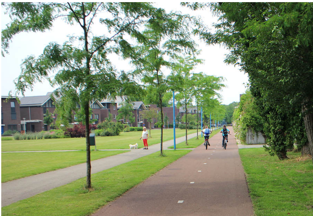
Abbildung 4.8 gepflegter Grünzug mit quartiersübergreifender Nahmobilitätsverbindung in Enschede / Niederlande: als Separationselement zwischen Zweirichtungsradweg und Gehweg dient ein Grünstreifen mit Baumallee. Bild: Dirk Schmidt 06-2015.
