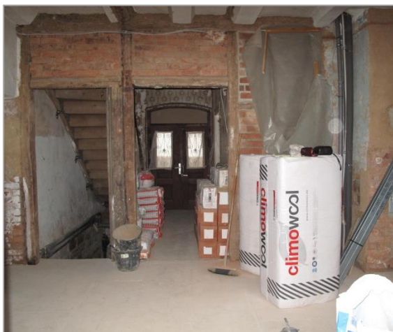
Sanierungsmaßnahme nach vorausgegangener Fachwerkberatung; Foto: D. Frieling
